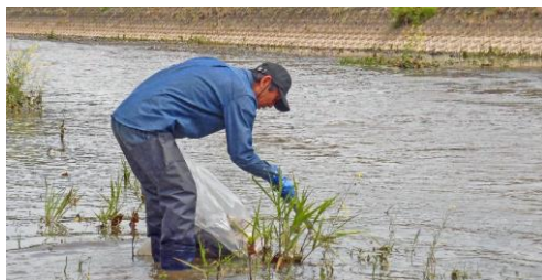
これは河川敷での作業です
