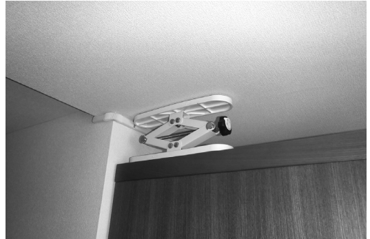
図1：タンスの固定。ベッド脇にあるために、ジャッキ式の器具でがっちり固定してある。
