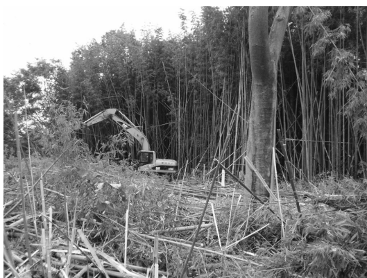
図16. 河川改修工事のための河辺林の伐採。犬上川河辺林においてマダケが高密度で生育している様子がよくわかる。
