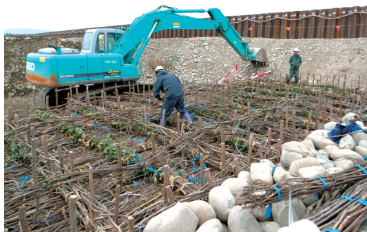
図4. 粗朶沈床工の施工現場。冬の洪水時に河道を閉め切って工事を行っている。
