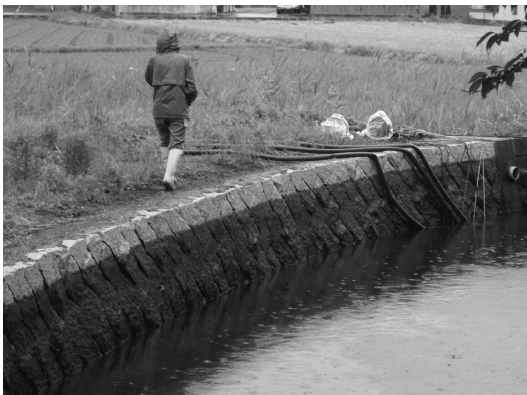
図5. 減水時のポンプによる給水作業。水路の護岸は生息地保全のために設置された石垣。
