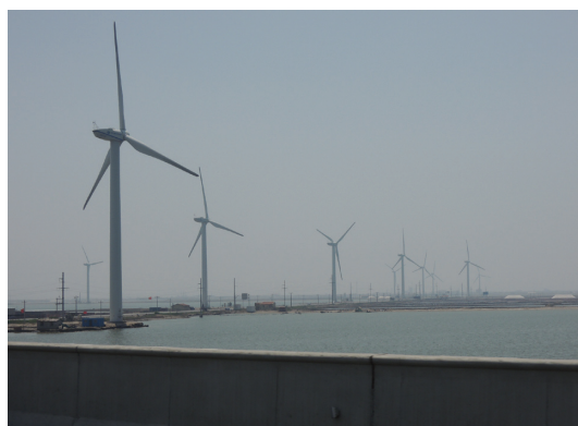
図9. 黄河河口近郊に立ち並ぶ風力発電施設。
