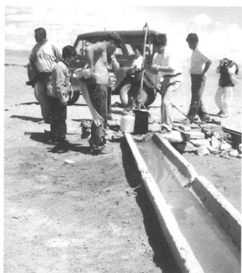
図7. ラクダへの給水施設。水路の始点に井戸がある、シャルガ・ゴビ。
