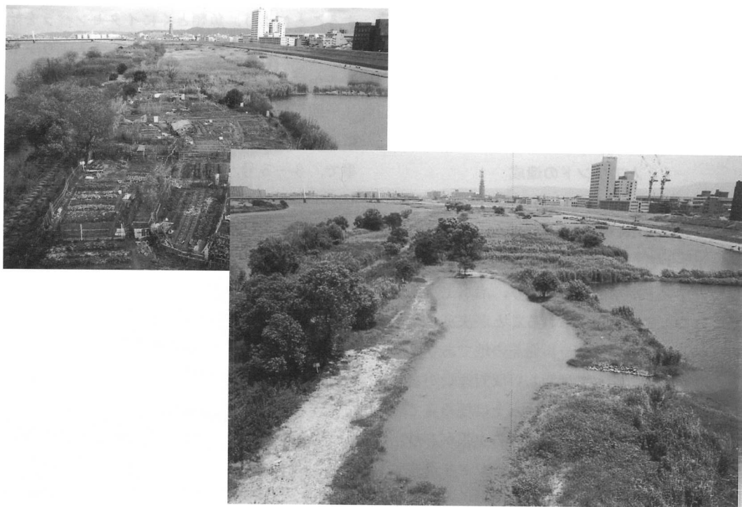
図18. 不法耕作地への浅いワンドの造成.
