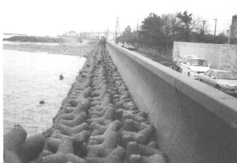
図5. 直立護岸, 消波ブロックによる防潮堤の整備.
